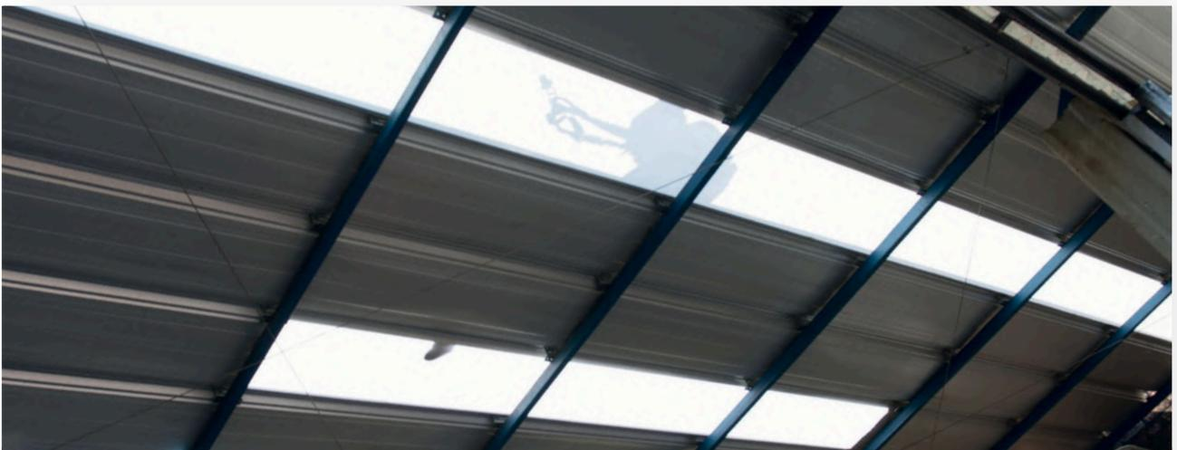
Nosso sistema ZIPLAN®, **permite a confecção de janela de iluminação** - quando se utiliza a telha translúcida no centro do telhado distribuindo os pontos de iluminação.
