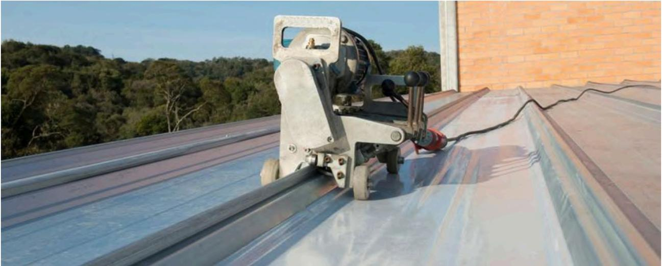
ZIPLAN, telha translúcida Planefibra®, fabricada em **PRFV (Polímero reforçado com fibra de vidro)**, com **fixação realizada através do sistema de zipagem** e adaptável aos diferentes modelos de telhas encontradas no mercado.
