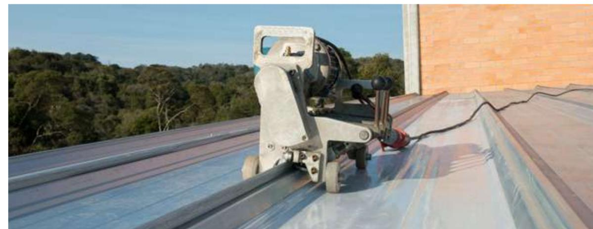
ZIPLAN, telha translúcida Planefibra®, fabricada em **PRFV (Polímero reforçado com fibra de vidro)**, com **fixação realizada através do sistema de zipagem** e adaptável aos diferentes modelos de telhas encontradas no mercado.
